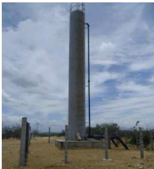
Figura 58 – Tanques de Alimentação Unilateral (TAU).
