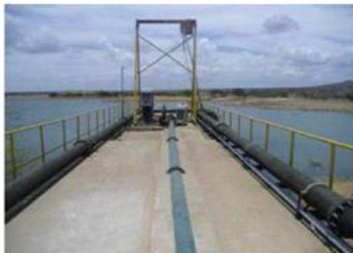
Adutoras de 250mm
