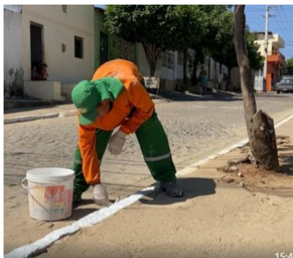
Figura 85 - Pintura manual de meio fio.
