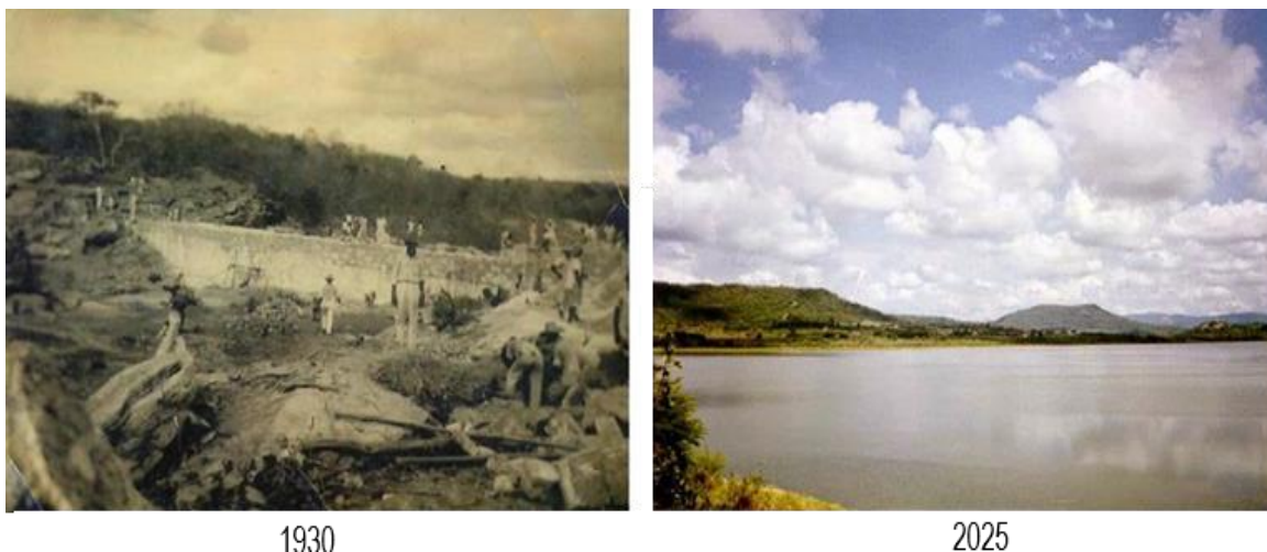
Figura 40 – Registro da construção do Açude Saco I (1930 - 2025)
