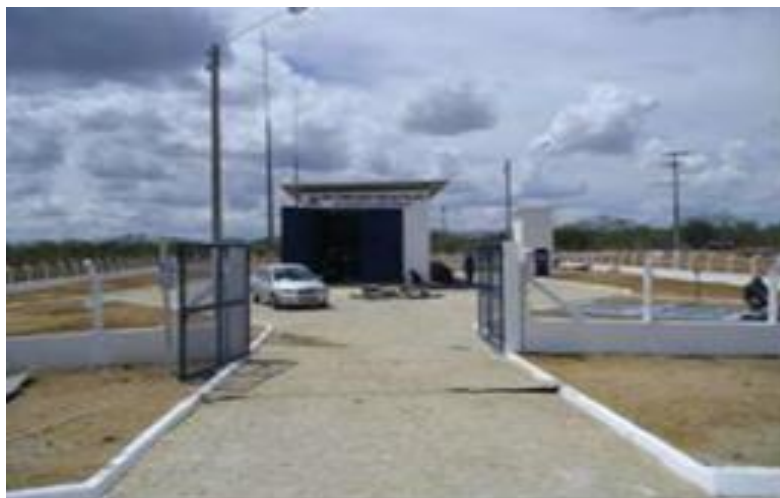
Figura 54 – Vista geral da Estação Elevatória EE2.
