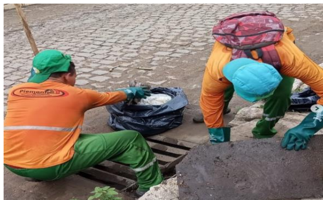
Figura 83 - Limpeza de bueiros.
