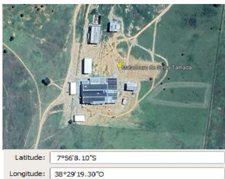
Figura 63 - Matadouro de Serra Talhada (vista aérea).
