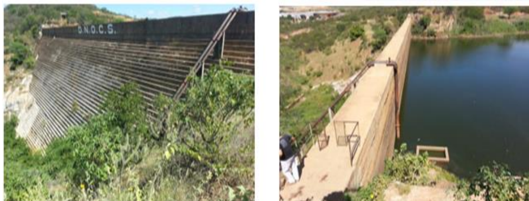
Figura 39 – Registros fotográficos do Açude Cachoeira II.
