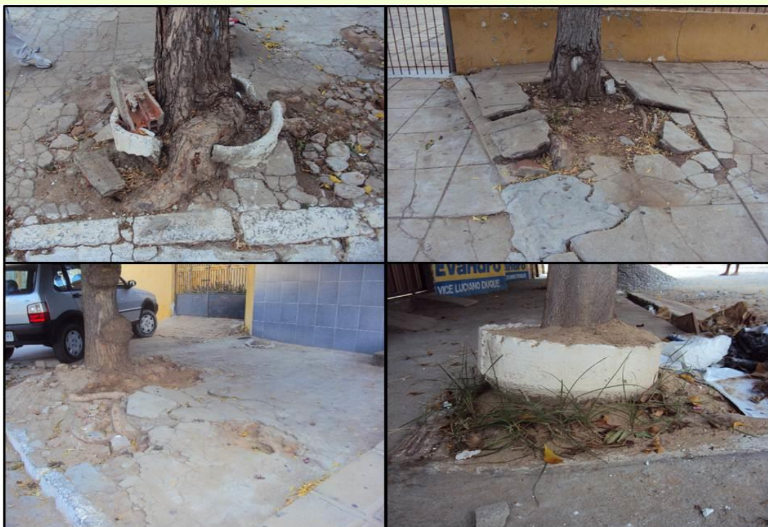
Figura 17 - Afloramento do sistema radicular provocado por Azadirachta indica (A, B, C) e Ficus benjamina , com utilização de manilha (D), no bairro Nossa Senhora da Penha Serra Talhada/PE, 2012.
